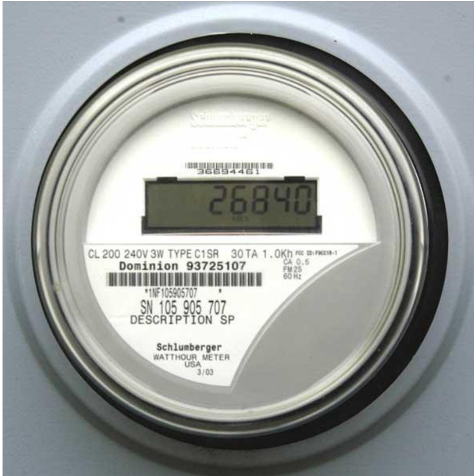
ภาพที่ 1.10 แสดงตัวอย่าง Watt hour meter
