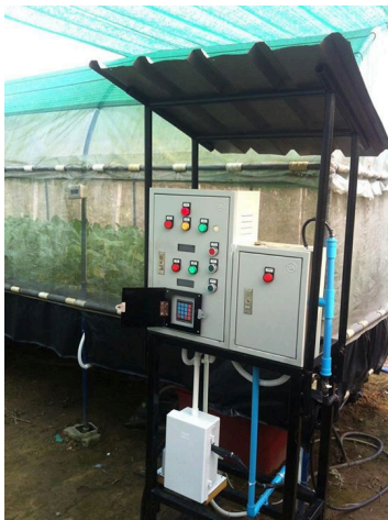
รูปที่ 7. เครื่องวัดค่า EC ถูกติดตั้งที่แปลงปลูกกะน้า
