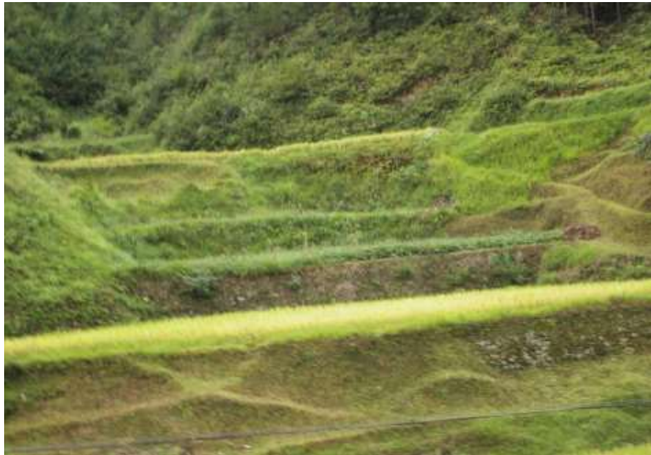
ภาพที่ 10.25 การสร้างคันดินกั้นน้ำ ที่มา: กองอนุรักษ์ดินและน้ำ (2544, หน้า 20)
